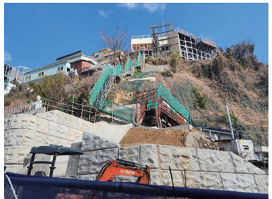
호천마을 경사형 엘리베이터 설치 현장
