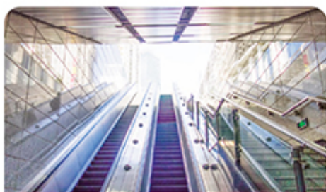
고덕역 E/S · 출구 추가 설치
